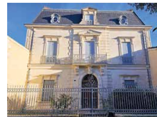
Rénovation de la façade et réfection de la toiture en ardoise.
