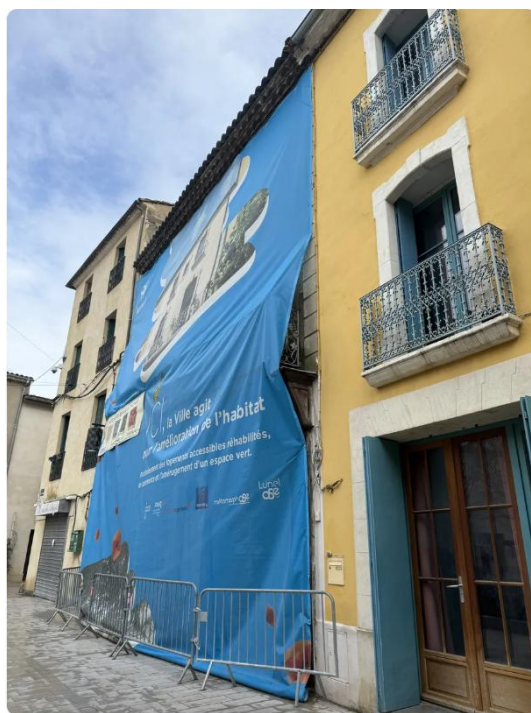
Depuis la place des Caladons, peu de détails du chantier transparaissent ©L.B./Hérault Tribune
