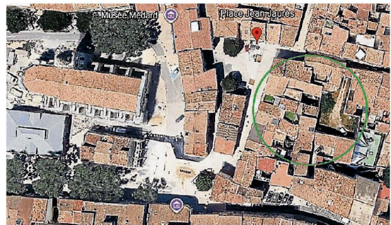
La partie publique de l'îlot Pharmacie, réhabilitée par la municipalité.
